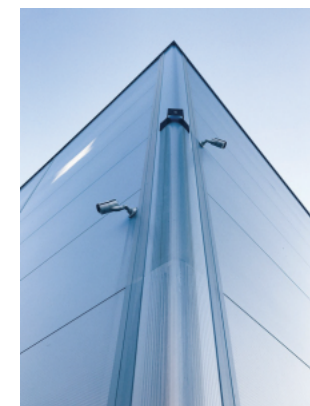
安防监控系统
