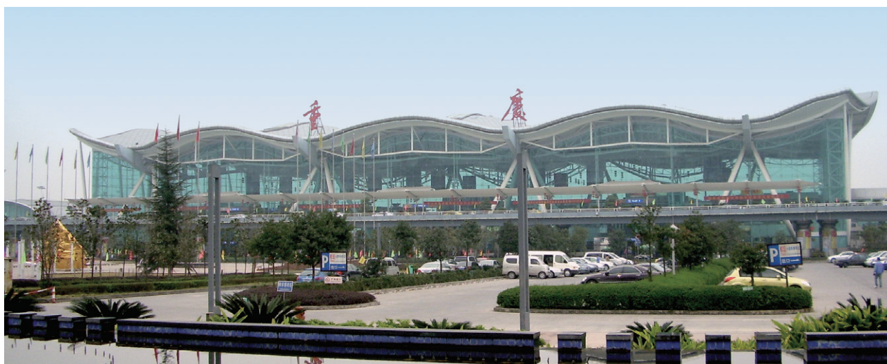
天诚智能集团样板工程·重庆江北国际机场
