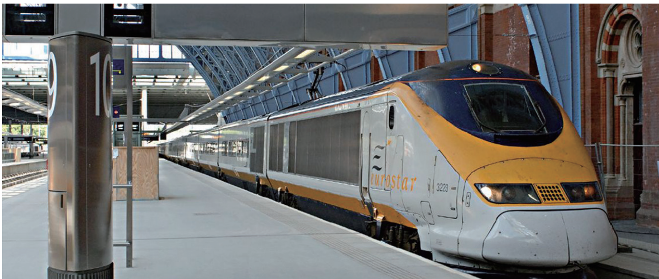
天诚智能集团样板工程·沪宁城际铁路沿线站台
