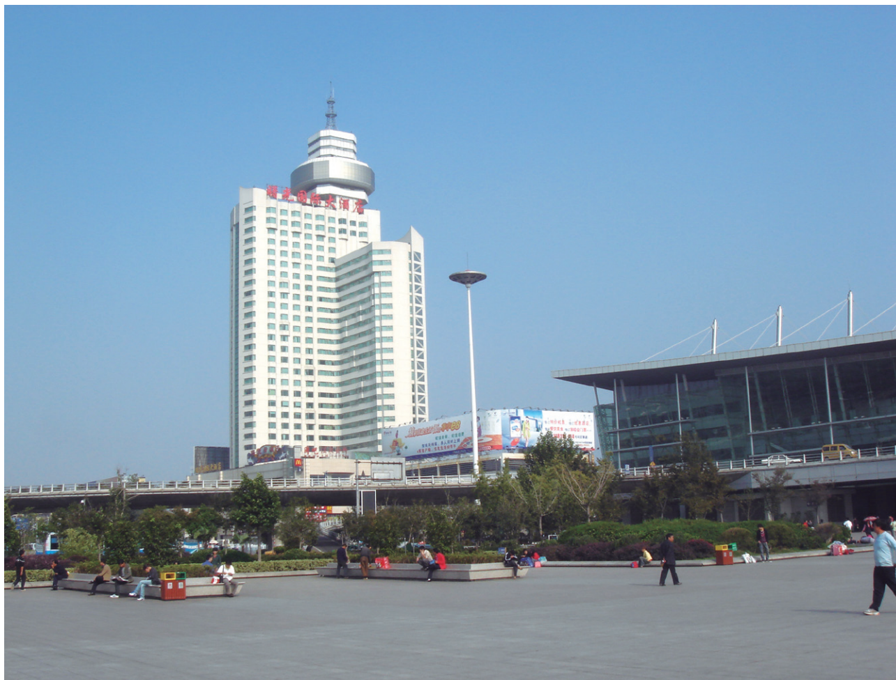
天诚智能集团样板工程·江苏电信大厦
