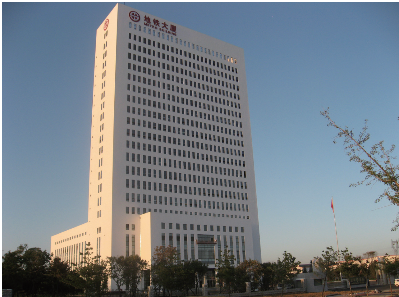
天诚智能集团样板工程·沈阳地铁大厦
