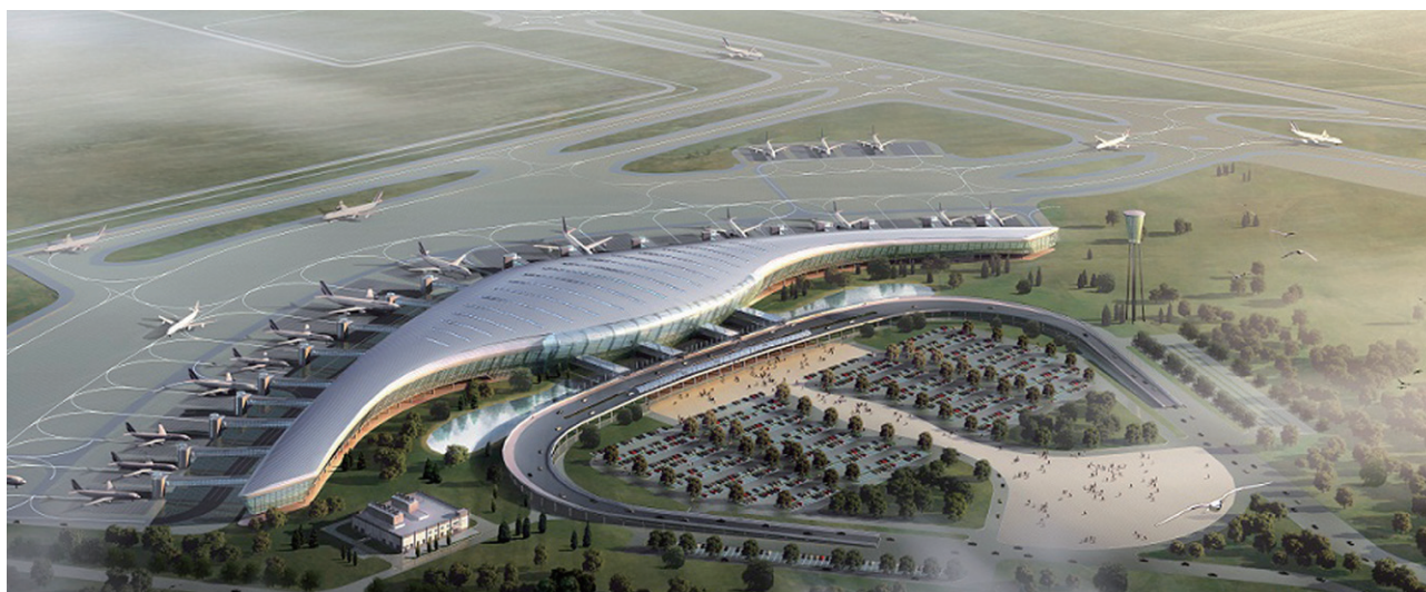
天诚智能集团样板工程·合肥新桥机场
